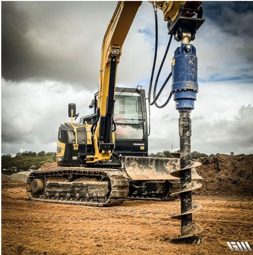
Figure 5 : Pelleteuse avec tarière pour percer le sol
